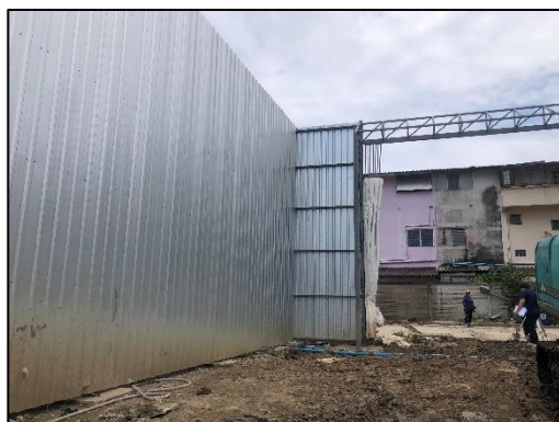
รูปที่ 2 รั้วโครงสร้างเหล็ก แผ่น Metal Sheet ล้อมรอบพื้นที่โครงการ
