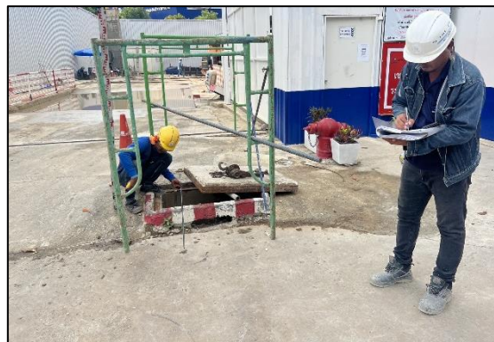
รูปที่ 39 ขุดลอกท่อระบายน้ำบริเวณด้านหน้าโครงการ
