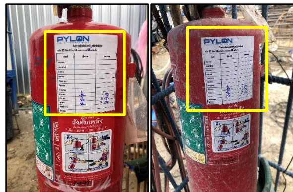
รูปที่ 67 การตรวจสอบสภาพของถังเคมีดับเพลิง
