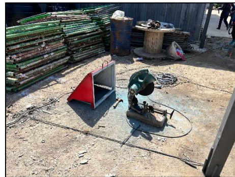
รูปที่ 11 การตัด หรือเจียร ทำในพื้นที่ที่กลุ่มผ้าใบ และผนังปิดด้านข้าง 3 ด้าน
