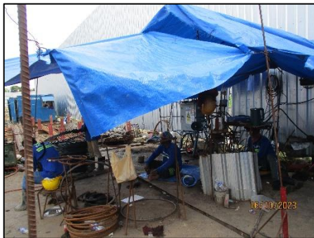
รูปที่ 11 การตัด หรือเจียร ทำในพื้นที่ที่กลุ่มผ้าใบ และผนังปิดด้านข้าง 3 ด้าน
